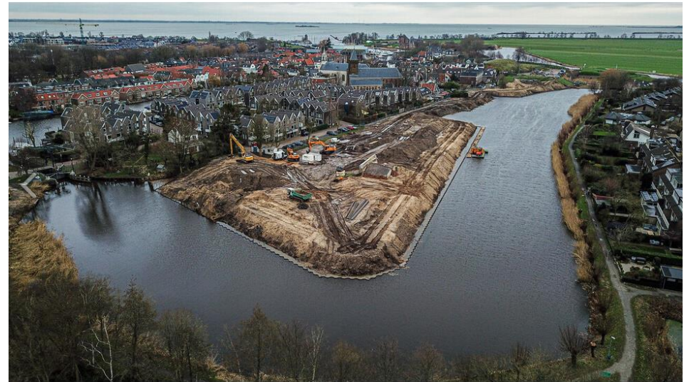
Afbeelding: werk in uitvoering op de vestingwal in Muiden
