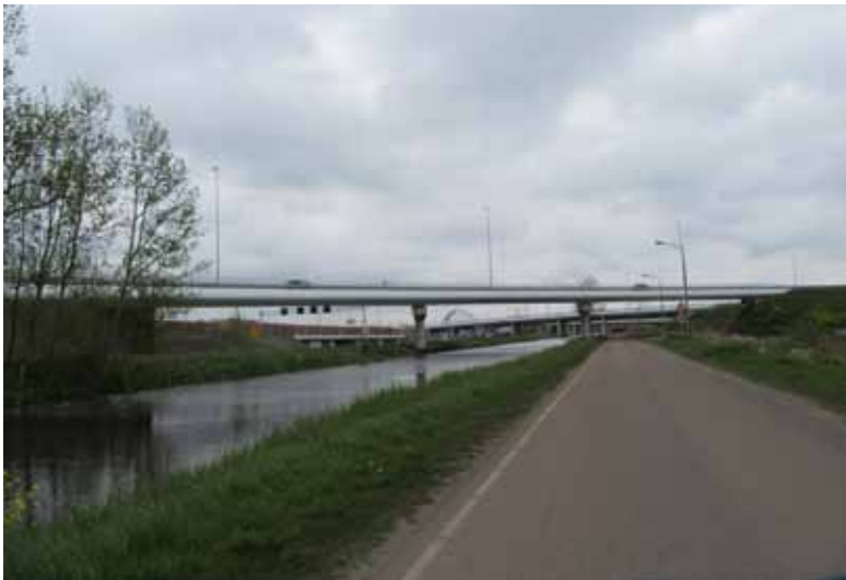
Viaduct Naardertrekvaart A6 / A1 - Zeldenrust met onder de A1 de grote ecopassage
