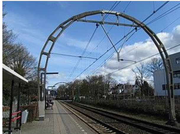
Figuur 19 Station Sportpark
