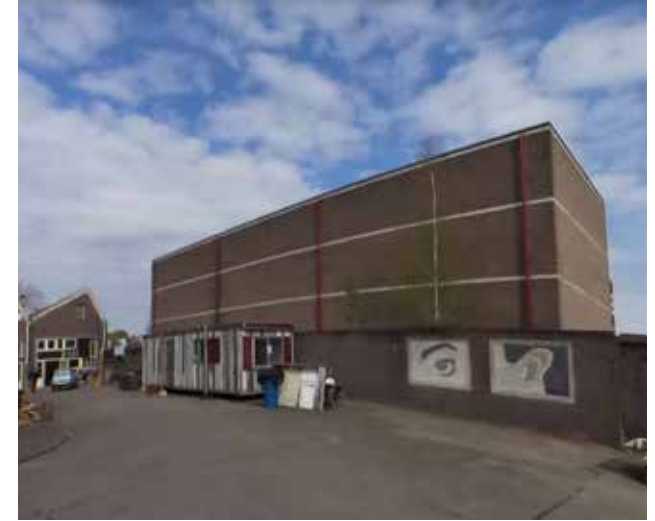
Energievoorzieningen aan de Noordzijde van de Werf
