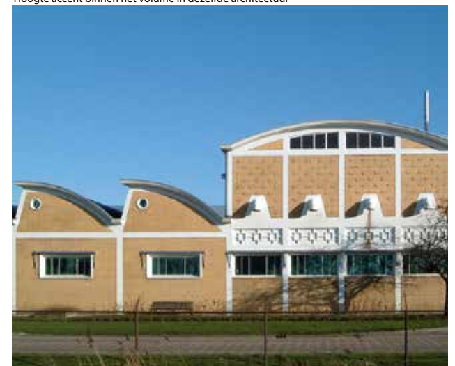
Tonnemafabriek - Sneek Hoogte accent met gelijke materialisatie en architectuur, met afwijkende dakvorm
