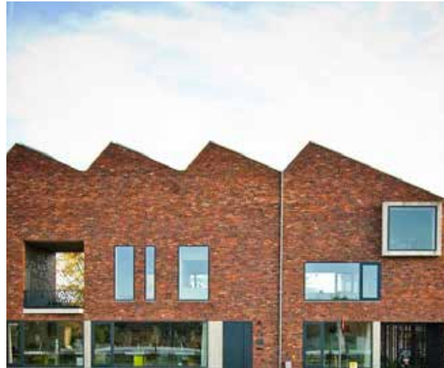
Referentie: Woon/werk gebouw - Oudenburg Moderne vertaling van sheddaken in baksteen gevel met open plint
