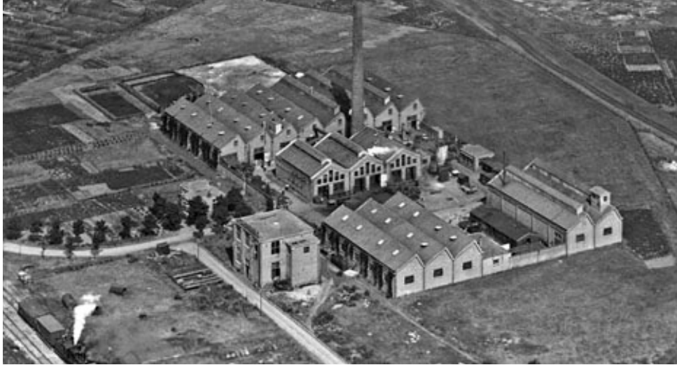
Gemeentewerf Hilversum als duidelijk afgebakend en herkenbaar fabriekscomplex
