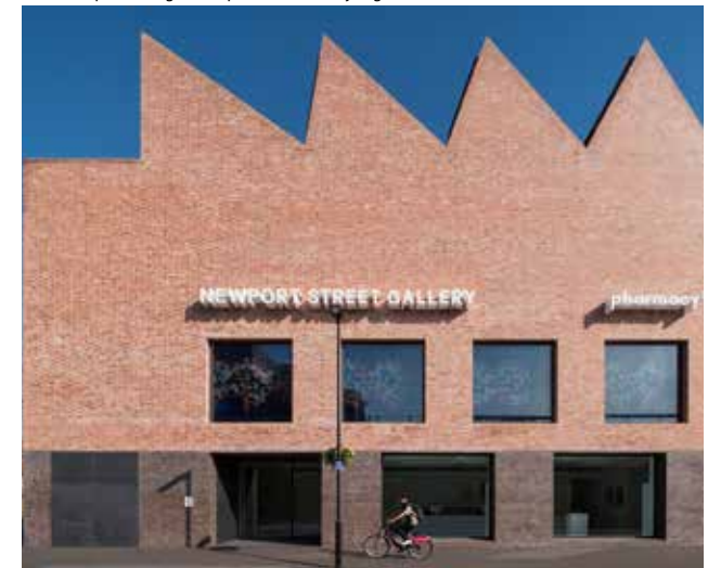
Referentie: Newport Street Gallery - London Moderne vertaling van sheddaken in baksteen gevel met open plint
