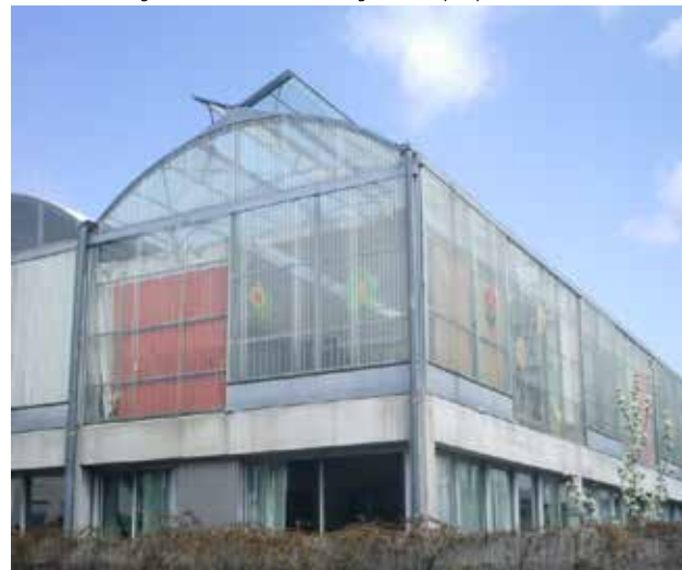
Referenties: Woningbouw - Mulhouse Eigen typologie met sterk industriële uitstraling in dakvorm
