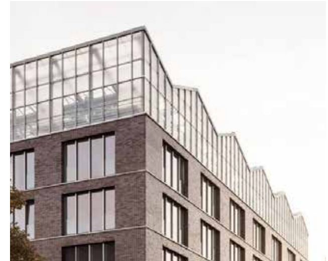
Referentie: Tollens Fabriek - Rotterdam Baksteen plint met glazen opbouw als verwijzing naar industriële architectuur
