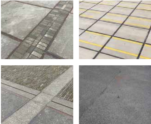
Lappendeken van materialen: stelconplaten, betonklinker, gebakken klinker en asfalt
