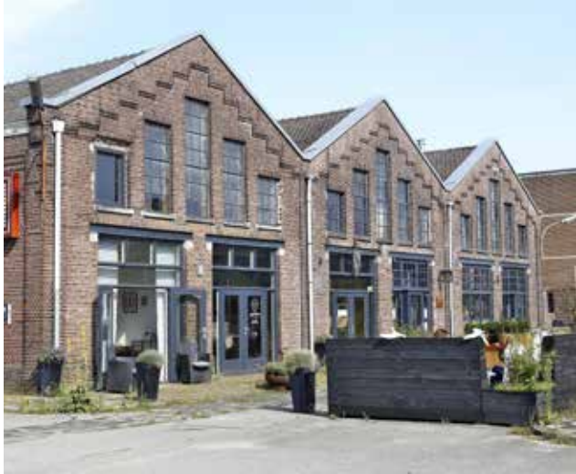
Het centrale plein met Chef aan de Werf, Mussenstraat 11
