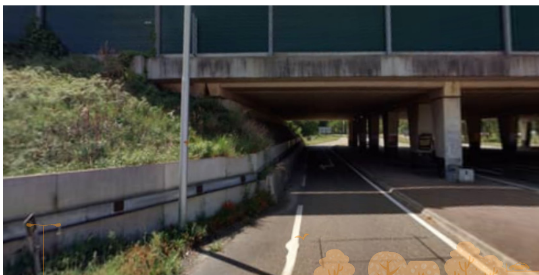
Huidige situatie oostzijde viaduct A1: geen ruimte voor hoogwaardig fiets- en voetpad
