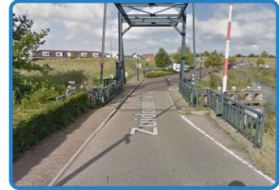
Kruispunt 9. Brug Zuidpolderweg-Naarderstraat
