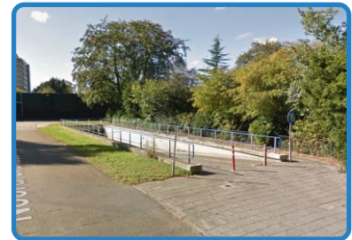
3. Tunnel naar Ceintuurbaan
