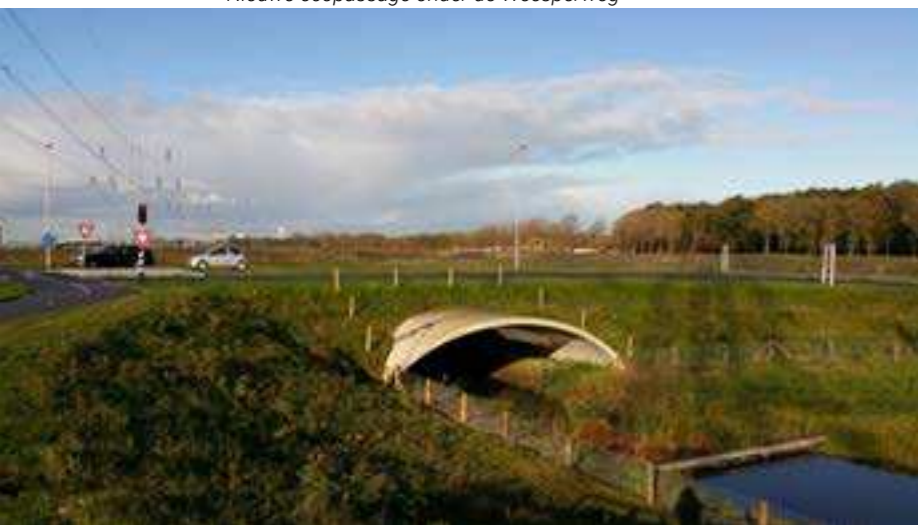
Nieuwe ecopassage onder de Weesperweg
